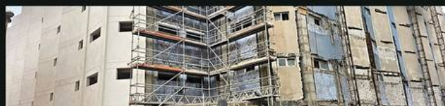
El paño terminado convive con el paño en ejecución.
