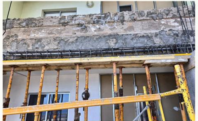
— Apeo de forjado con puntales alineados en vertical.
