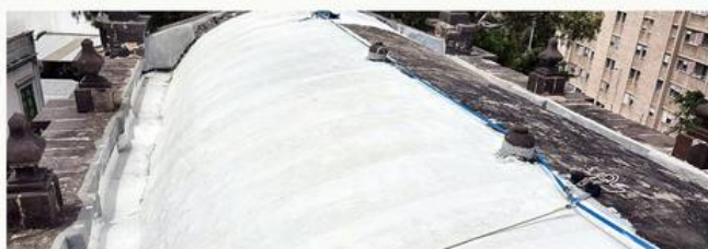
Bóveda terminada con membrana continua.
