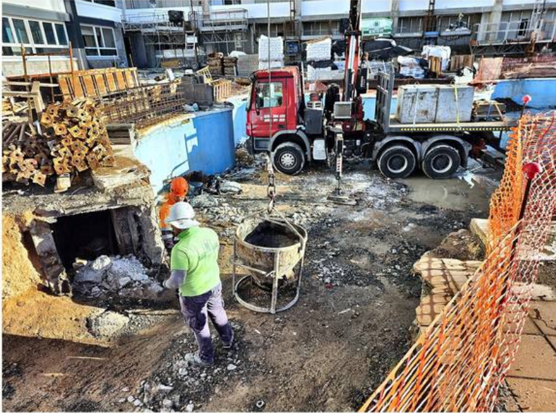
— Zona de acopio y amasado con delimitación perimetral. Personal con casco y alta visibilidad.
