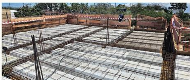
Forjado replanteado y ferrallado, listo para hormigonar.
