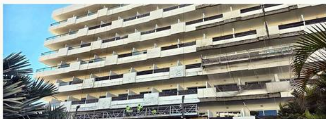
Plataforma suspendida en el frente de trabajo, con el hotel en funcionamiento.
