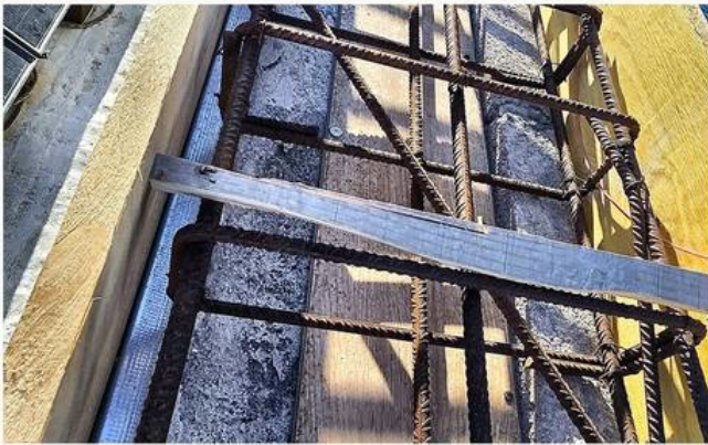
— Ferralla de refuerzo montada en obra.
