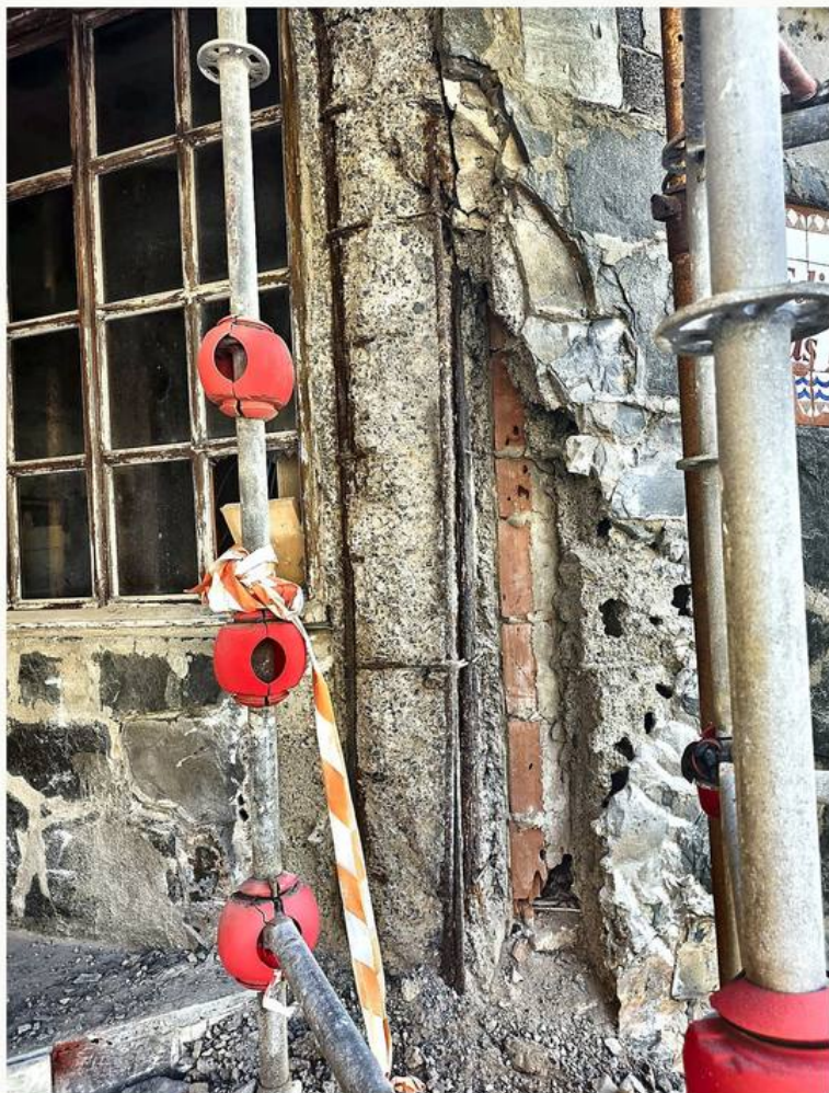
Apuntalamiento con puntales metálicos y durmientes de reparto antes de descubrir el pilar.
