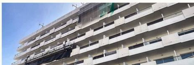
Lona de recogida bajo el frente y protección de coronación; la esquina curva se resuelve sin interrumpir el paso de clientes.
