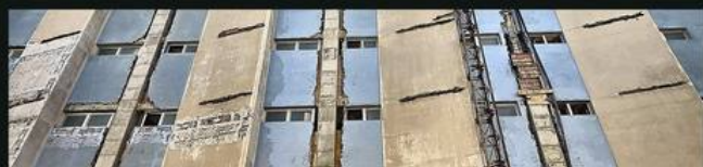
Frente de trabajo con plataformas suspendidas y montacargas de obra.
