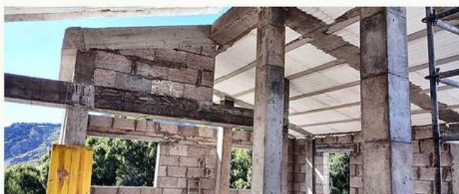
Pórticos y jácenas ejecutados, con los huecos de fachada ya definidos.
