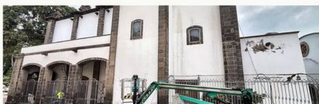
Plataforma sobre orugas con estabilizadores: huella reducida, sin andamio y con la entrada al templo siempre libre.
