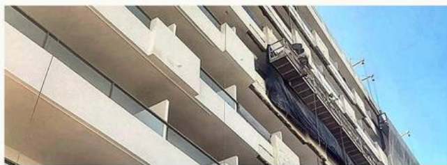
Frentes de forjado y antepechos saneados antes del acabado.
